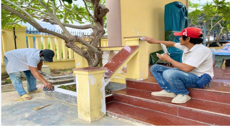
TRIỂN KHAI CẢI TẠO, SỬA CHỮA CÁC NHÀ BIA GHI DANH LIỆT SĨ TRÊN ĐỊA BÀN PHƯỜNG
